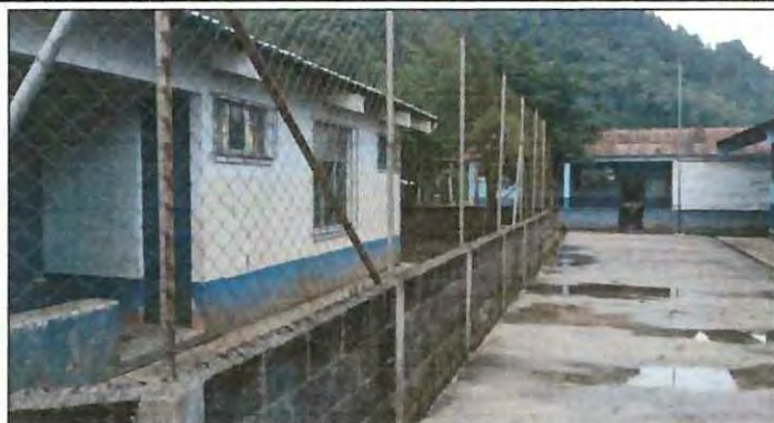
Foto 1: MURO PERIMETRAL LADO FRENTE A LA ESCUELA
