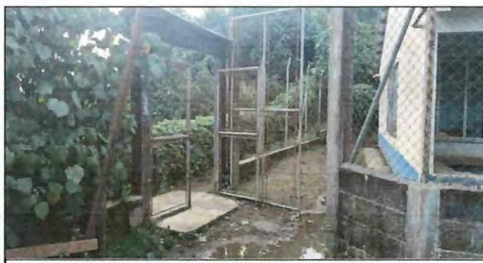
Foto 5: SUSTITUCION DE PORTON ENTRADA PRINCIPAL
