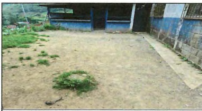
Foto 6: LOSA DE PATIO
