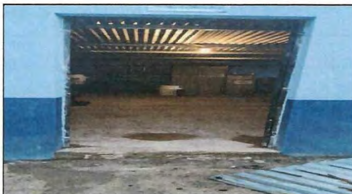
Foto 4: COLOCACION DE PISO CERAMICO SOBRE PISO
