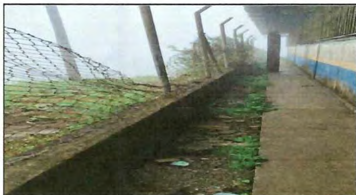
Foto 3: REPARACION DE MURO LADO ESTE DEL CENTRO EDUCATIVO
